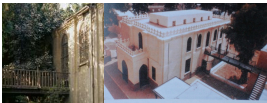
Sinagoga de Ben Ezra antes y después de la última restauración.
