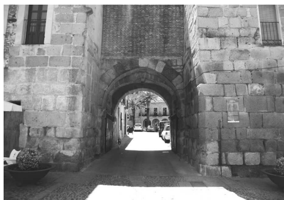
Estado actual de la puerta romana de San Pedro o del Sol de Coria
