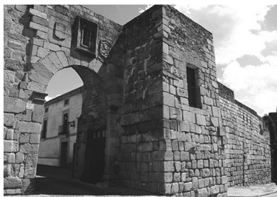
Estado actual de la muralla romana de Coria
