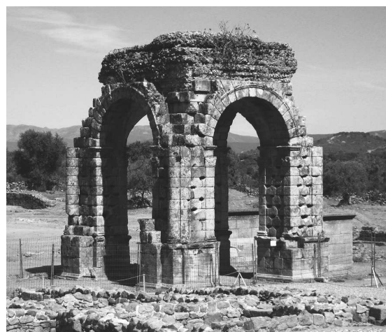
Estado actual del pórtico de Cáparra
