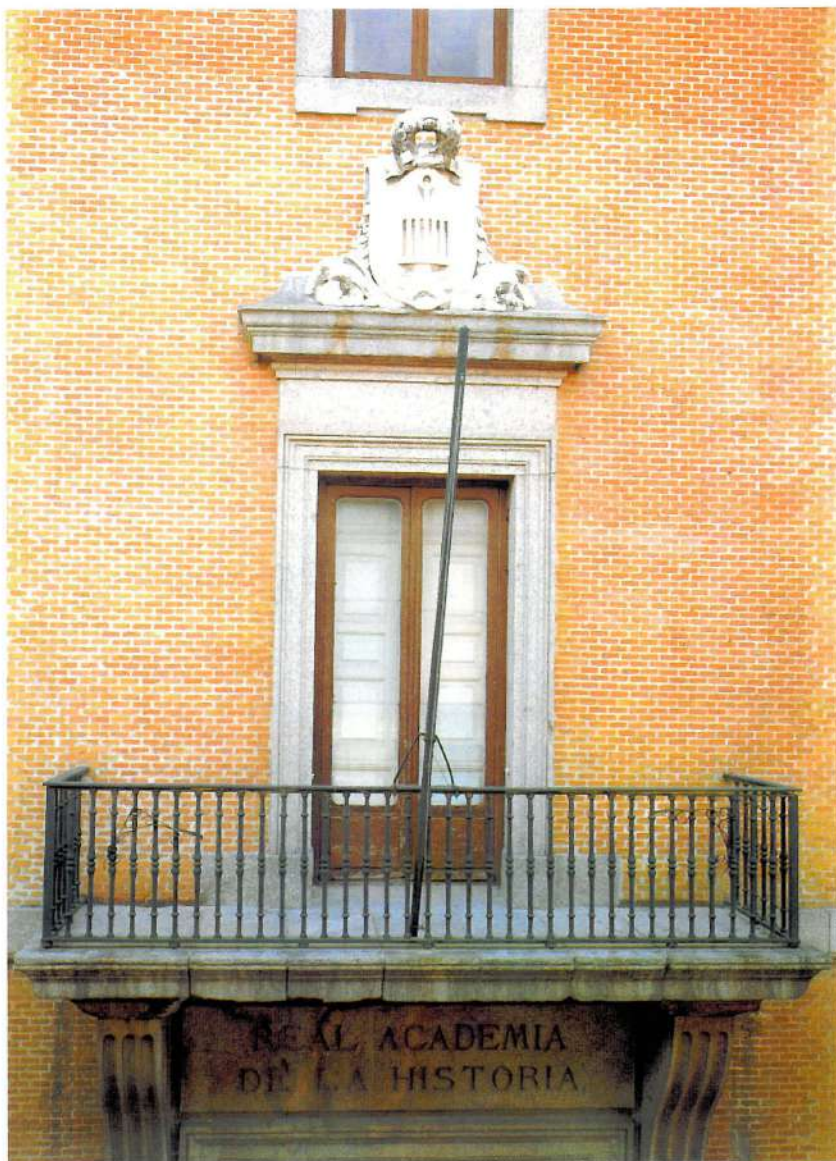
Balcón de la fachada del Palacio del Nuevo Rezado.
