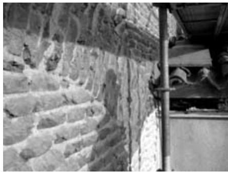
Uno de los arcos de descarga en el muro medianero.
