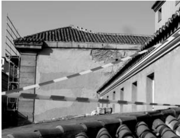
Vista del lado sur de la medianería.
