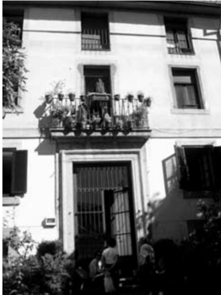
Casa del Consul de Francia: detalle de la portada, con cinco ejes verticales de vanos y balcón con barandilla “cobijando” la portada.
