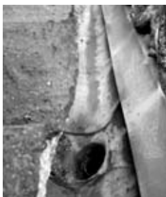
Cazoleta en plomo en canalon de cubierta.
