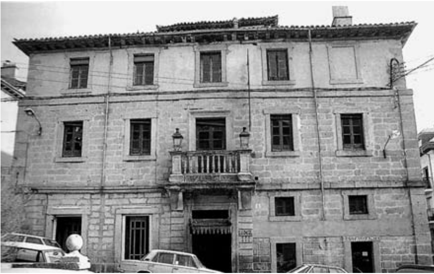
Casa del Marqués de Campo Villar, con sus cinco ejes, y balcón soportado por mensulas laterales sobre a portada.
