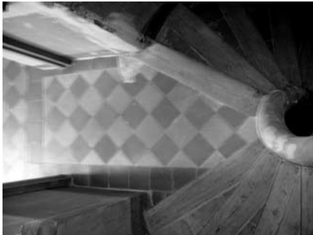
Escalera de caracol interior hasta la cubierta.
