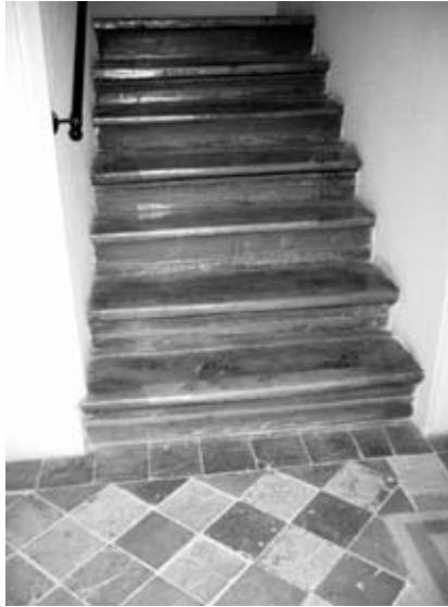
Escalera situada al este de la principal.
